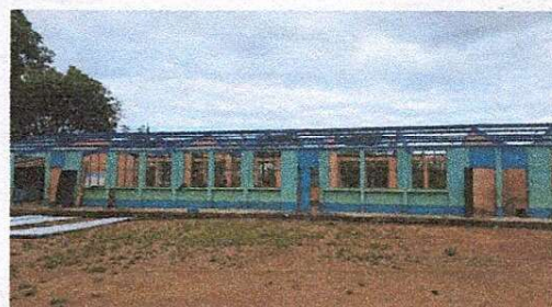
Foto 2: se realiza el mantenimiento de las estructuras del centro educativo. Aplicación de pinturas antióxidantes.
