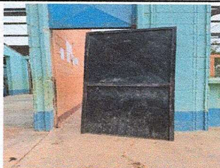
Foto 3: Se observa y cambio y mantenimiento de las cuatro puertas del modulo educativo
