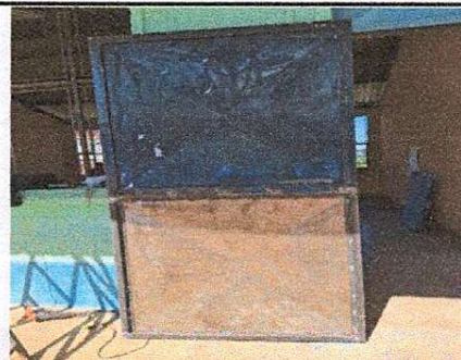
Foto 4: se observa el mantenimiento y cambio de las cuatro puertas del modulo educativo.
